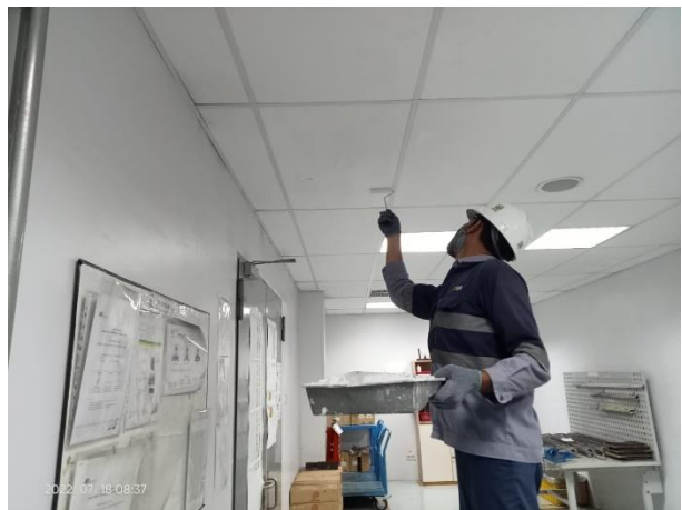
Pengecatan ceiling dan plafon
