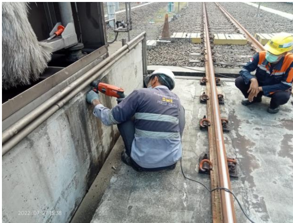
Pembuatan jalur drain genangan air ACWS
