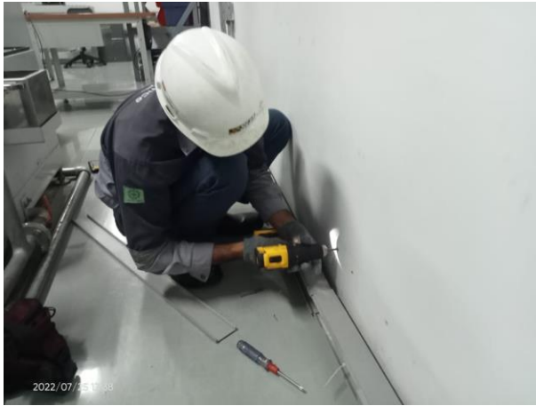
Pembuatan support pipa drainage AC
