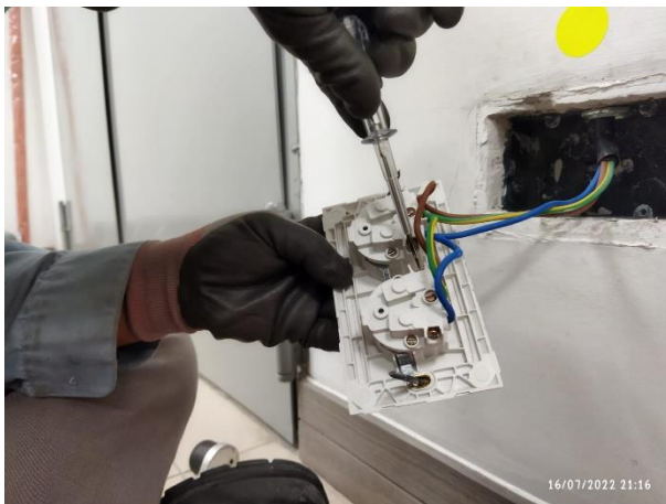
Pengecekan dan terminasi Socket Outlet
