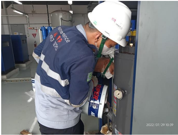
Penggantian oli Air Compressor System
