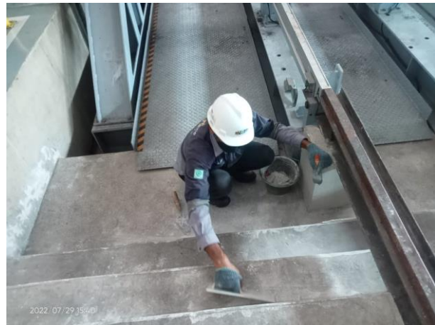
Perbaikan anak tangga area Bogie Lifter
